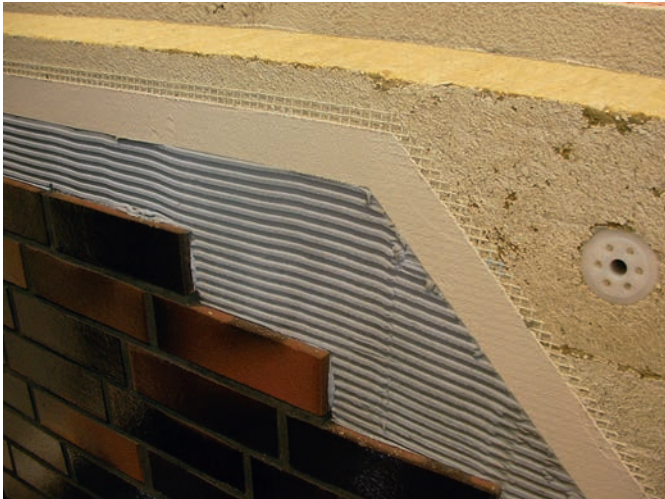
Bild 8. Klinkerriemchen als Deckschicht von WDVS bilden eine robuste und wartungsfreie Wandbekleidung Fig. 8. Clinker tiles as top layer of ETICS form a robust and maintenance-free wall covering
