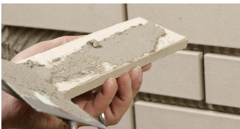
**2.** Für das Ansetzen von Klinkerriemchen sollte ausschließlich das kombinierte Floating-Buttering-Verfahren angewendet werden, bei dem sowohl der Untergrund als auch die Rückseite des Riemchens glatt mit dem Kleber bestrichen wird. Dabei kommt es zu einer deutlichen Erhöhung der erreichbaren Haftzugfestigkeit gegenüber dem Floating-Verfahren.
