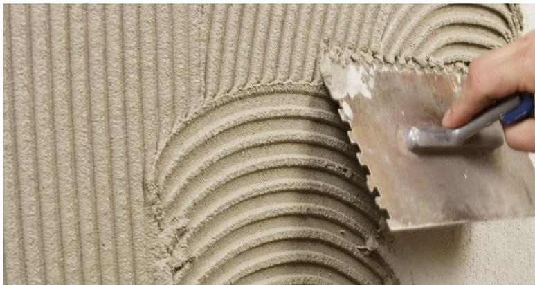
**1.** Der Mörtel wird in zwei Arbeitsgängen auf die Ansetzfläche aufgebracht. Im ersten Arbeitsgang werden die Ansetzflächen mit einer Glättekelke dünn mit Klebemörtel überzogen. Auf die frische Schicht wird im zweiten Arbeitsgang die für die Abkämmung erforderliche Schichtdicke aufgetragen. Die so hergestellte Mörtelschicht wird mit einem Kammspachtel, schräg mit einem Abstellwinkel von ca. 50 Grad, abgekämmt.
